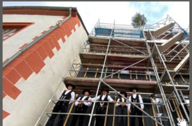
...es stehe fest in Ewigkeit Wir feiern das Richtfest für den Neubau „Haus am Baum“ mit 110 Appartements.
