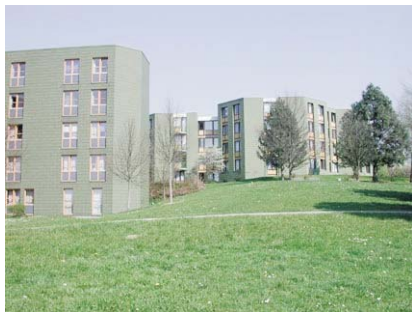
Fassaden der alten Gebäude der Wohnanlage Tarforst
