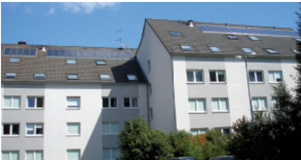
In der Wohnanlage Olewig heizen 60 m 2 Solarfläche 4670 Liter Pufferspeicher auf.
