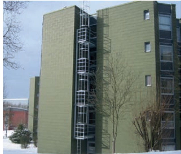
Fluchttreppe für den Brandfall
